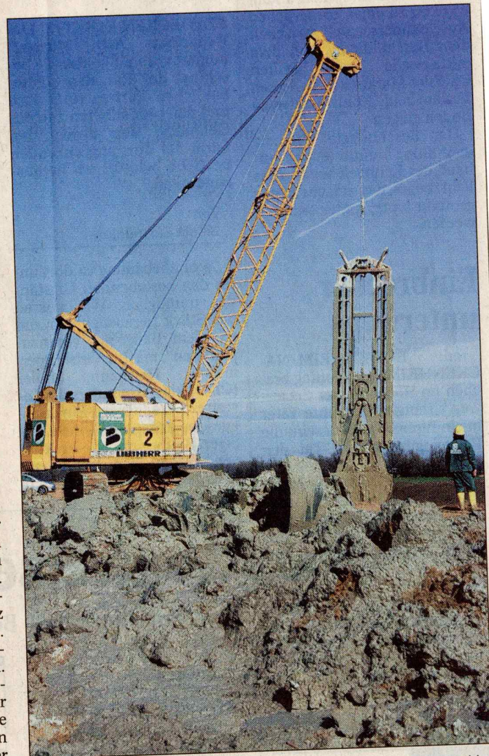
Mit Hilfe dieses Ungetüms entsteht am Deich eine Dichtwand im Boden. Der ausgebaggerte Graben wird mit einem Ton-Zement-Gemisch gefüllt. Fotos: hzb / Stefan Sämmer
