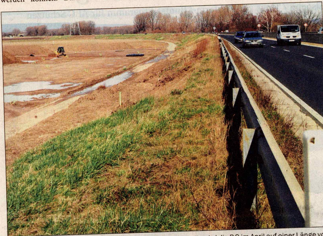
Zwischen der Einmündung der L413 und der Agip-Tankstelle wird die B9 im April auf einer Länge von 250 Metern gesperrt, um das Ein- und Auslassbauwerk für den Polder zu errichten. Der Verkehr wird für ein Jahr über eine provisorische Trasse – die vorbereitenden Arbeiten für die Aufschüttungen sind schon zu sehen (links) – um die Baustelle herumgeleitet.
